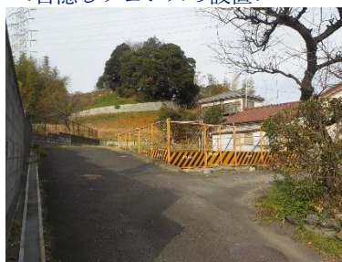
<目隠しフェンスの設置>
