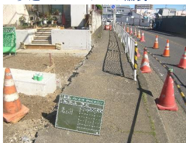
<歩道のアスファルト舗装>
