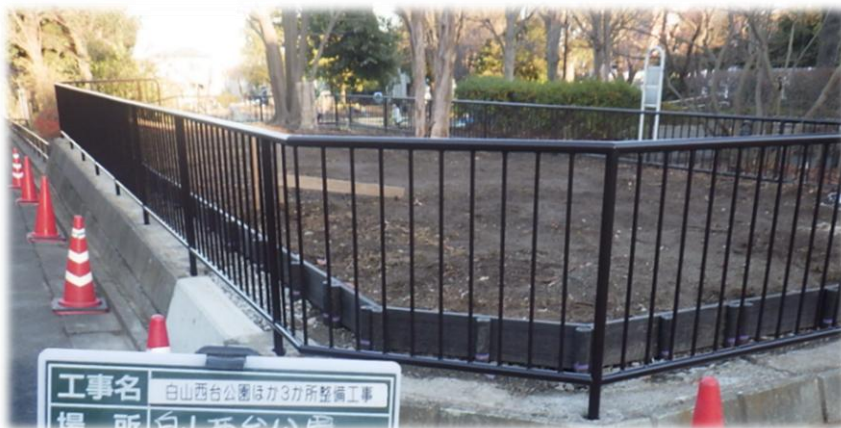
白山西台公園の縦格子柵の改修工事を行わせていただきました
