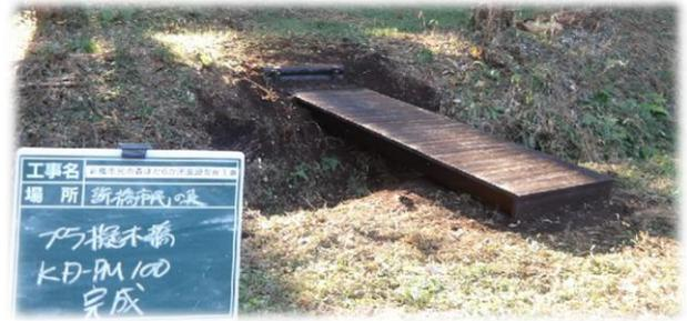
＜新橋市民の森＞ 経年により劣化した木橋を撤去しプラ擬木橋と階段1段の設置をしました。
